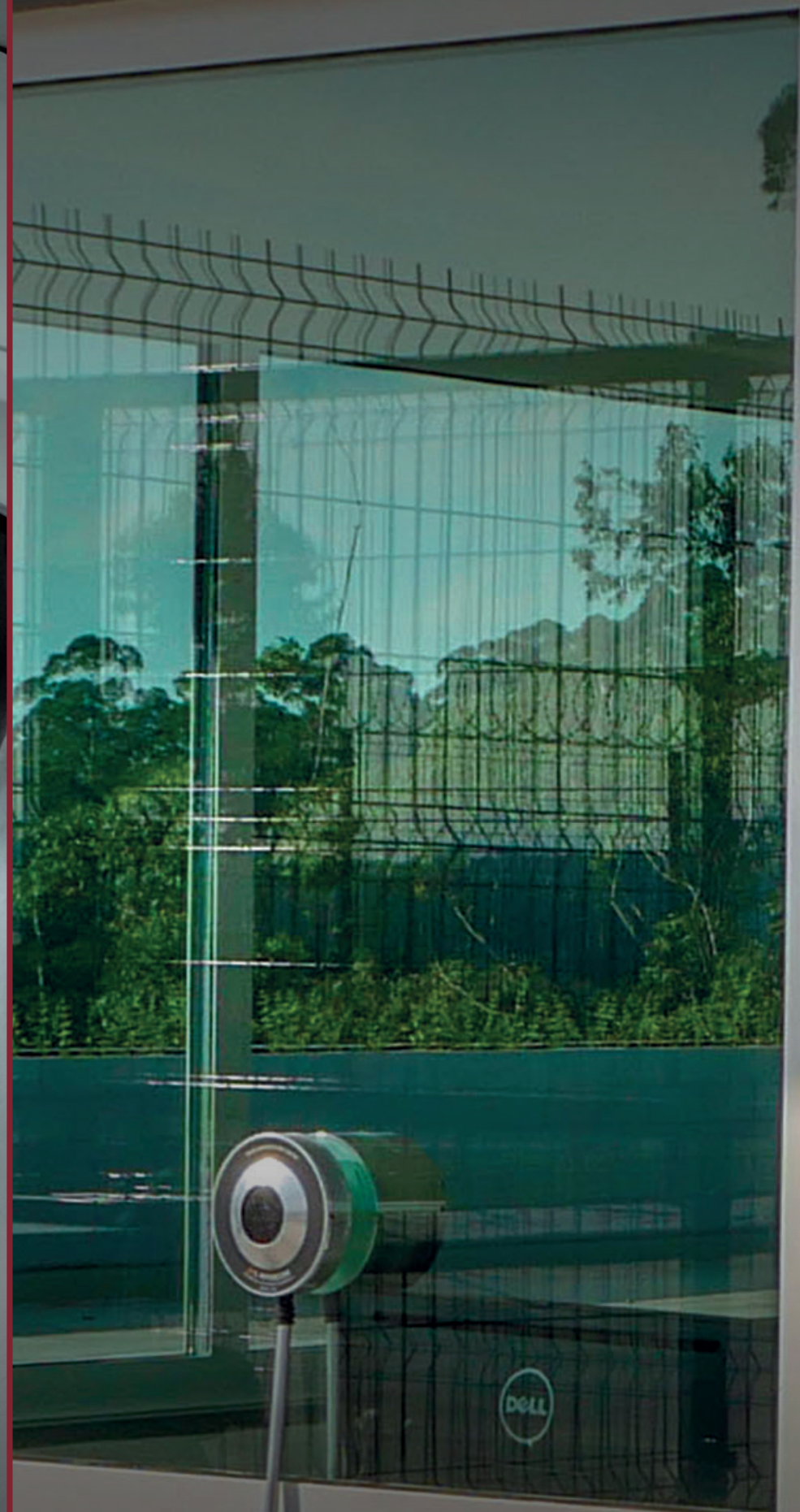
▼ Portaria blindada com controle de acesso monitorado 24 horas
